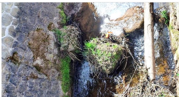
Obr. 43 Přepážka 5, pohled z PB (vlevo), a po proudu. Kromě poškozené přehrážky lze očekávat poškozený obklad PB zdiva („výplň“ naplaveninou)
