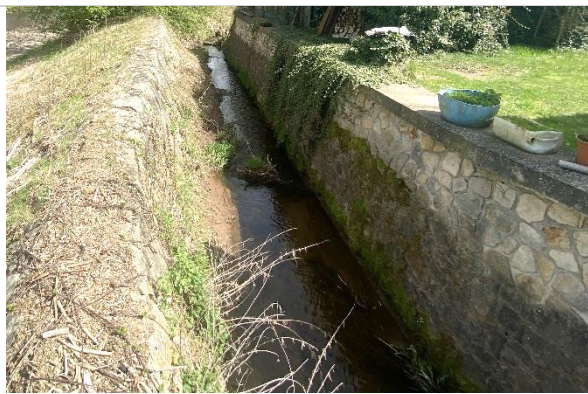
Obr. 44 Bazén 6 (délky cca 25 m), opěrné zeď na PB (dle projektu sklon 5:1). Na LB dle projektu strmá rovinanina ve sklonu 2:1, při realizaci pravděpodobně změněno na o beton s obkladem se spárováním
