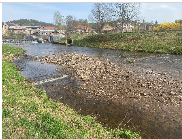
Obr. 3 Nánosy pod jezem JUTA
