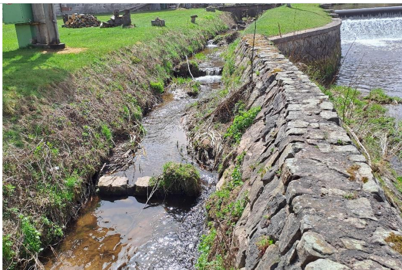
Obr. 52 Střední horní část RP, břehová opevnění
