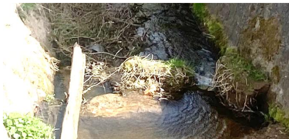
Obr. 43 Přepážka 5, pohled z PB (vlevo), a po proudu. Kromě poškozené přehrážky lze očekávat poškozený obklad PB zdiva („výplň“ naplaveninou)
