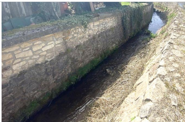
Obr. 44 Bazén 6 (délky cca 25 m), opěrné zeď na PB (dle projektu sklon 5:1). Na LB dle projektu strmá rovinanina ve sklonu 2:1, při realizaci pravděpodobně změněno na o beton s obkladem se spárováním
